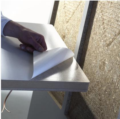
Entfernen Sie die an der Rückseite des Ambientone No. 2 Universalmoduls befindlichen Transportsicherungen.
